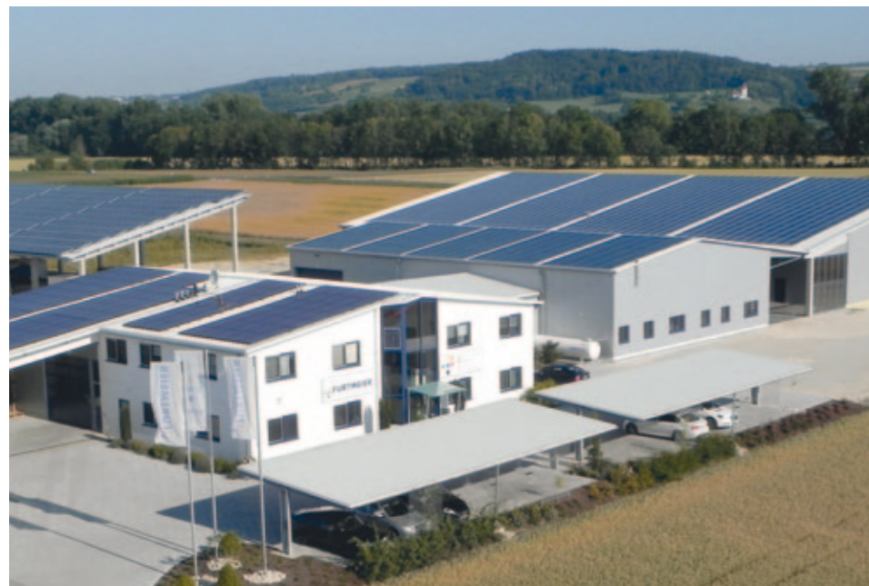
Firmenzentrale der Furtmeier Dienstleistungsgruppe in Genderkingen mit der neuen Lagerhalle im Hintergrund, Foto: Furtmeier
